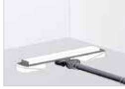
Duş kanalı tesisata ve koruyucu straforu tıkanmaya karşı üzerine koyunuz.
