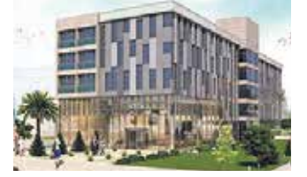
KOÇ İNŞAAT - İZMİR
